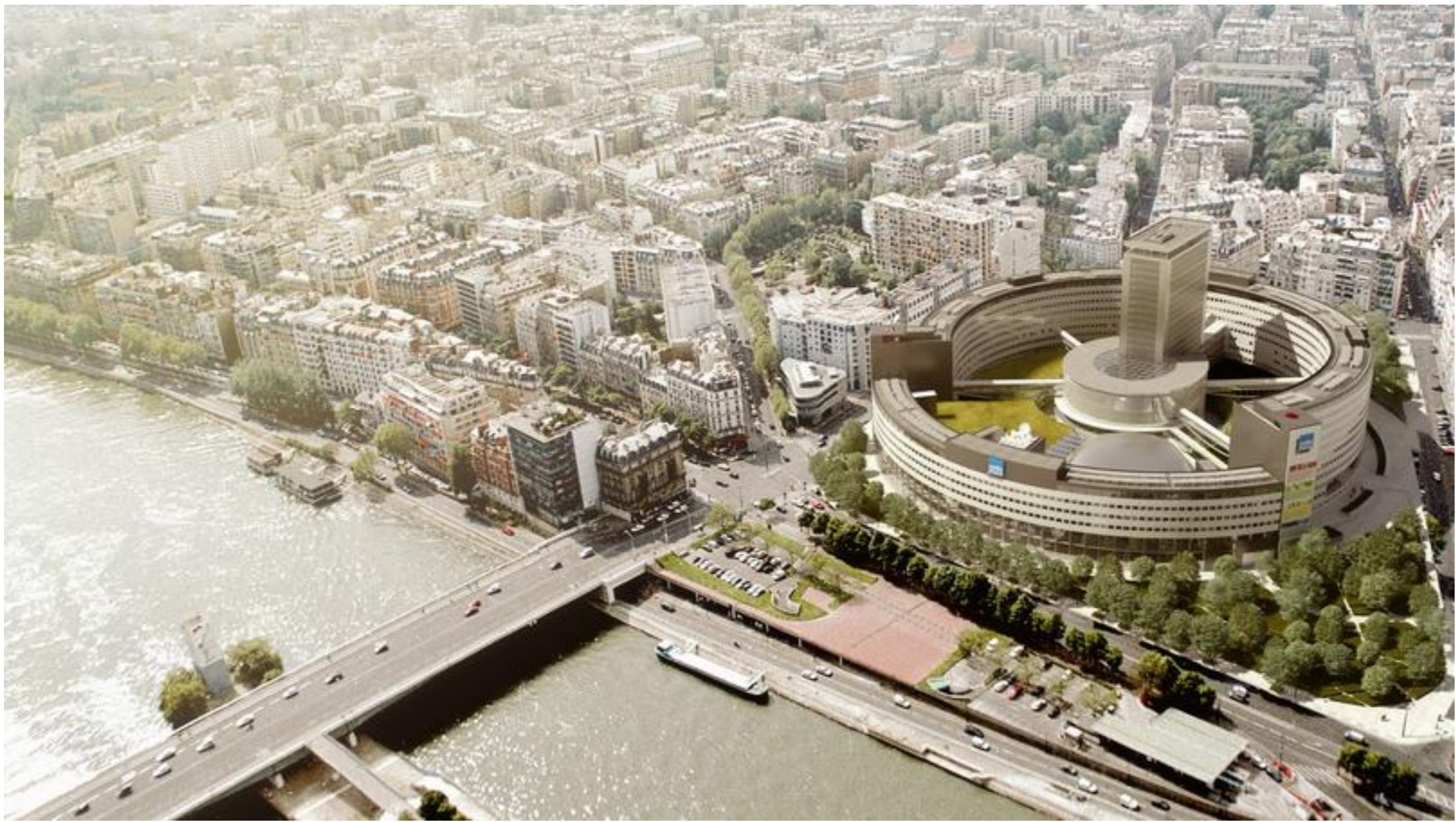
Restauration de la maison de la Radio par AS.Architecture-Studio. Crédits photo : AS.Architecture-Studio
